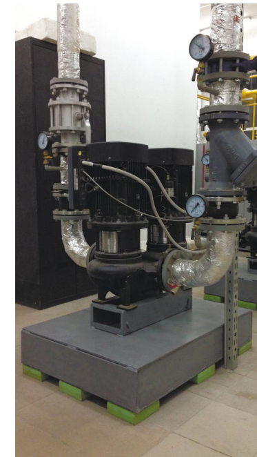
Виброизоляция насосной группы Виброизоляторы: Vibrofix Block Объект: жилой комплекс, Киев
