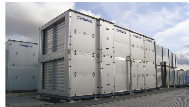
Виброизоляция вентиляционных установок Виброизоляторы: Vibrofix Level Объект: ТРЦ "Республика", Киев
