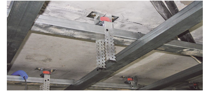
Каркас звукоизоляционного подвесного потолка KNAUF D112 на эластичных креплениях Vibrofix PU
