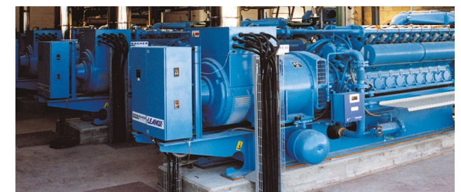
Виброизоляция генератора с помощью Vibrofix Block
